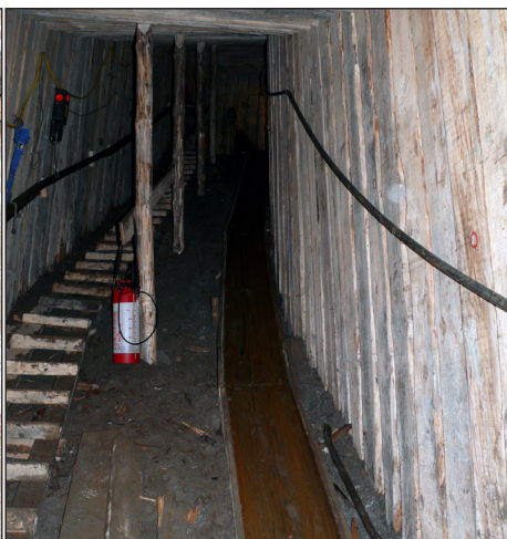
Fot. 11. Bieg czwarty schodów Regis w trakcie prac zabezpieczających
