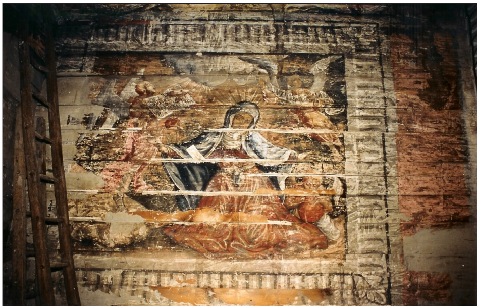
Fot. 8. Polichromia na wschodniej ścianie kaplicy Passionis w trakcie prac konserwatorskich
