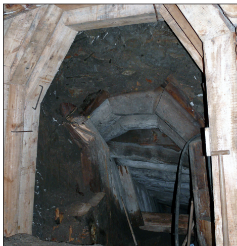
Fot. 10. Przebudowa pierwszego biegu schodów Regis
