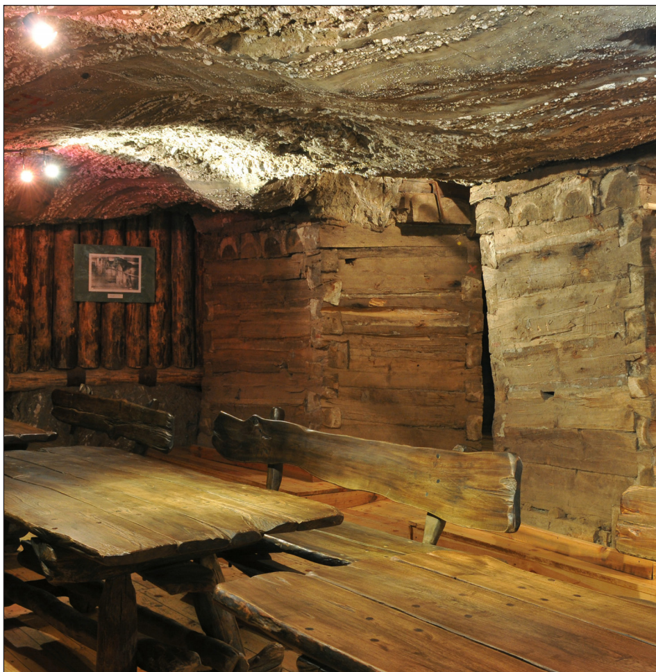
Fot. 4. Stajnia w komorze Mysiur po pracach zabezpieczająco – adaptacyjnych z przełomu XX/XXI w.
