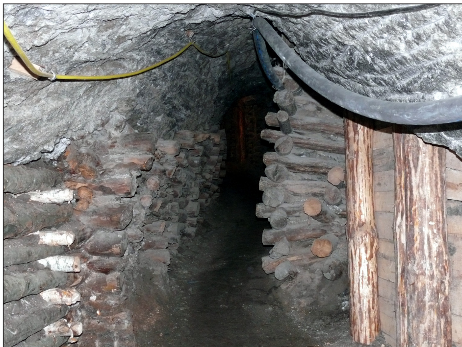
Fot. 15. Komora Śmierdziuchy Dolna na Zejściu Kalwaria w trakcie prac górniczo-konserwatorskich
