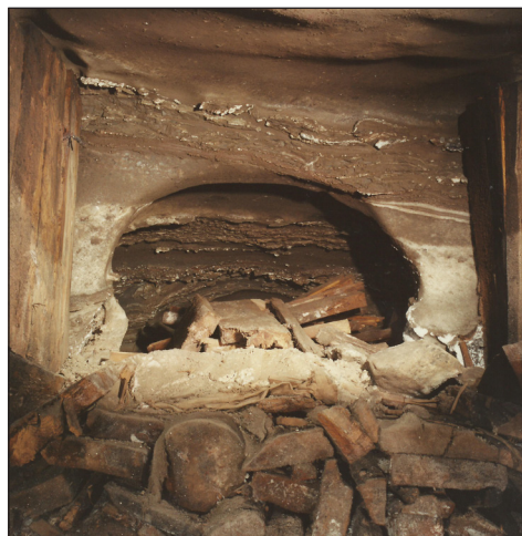
Fot. 12. Podsadzka wypełniająca przestrzeń kaplicy Krucyfiks
