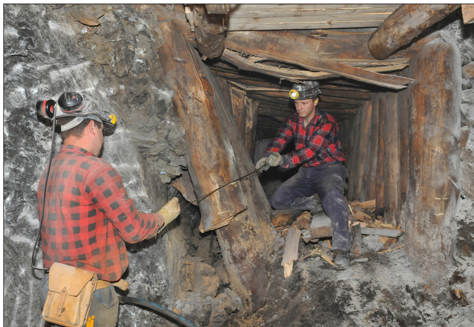
Fot. 6. Przebudowa wschodniego odcinka podłużni August
