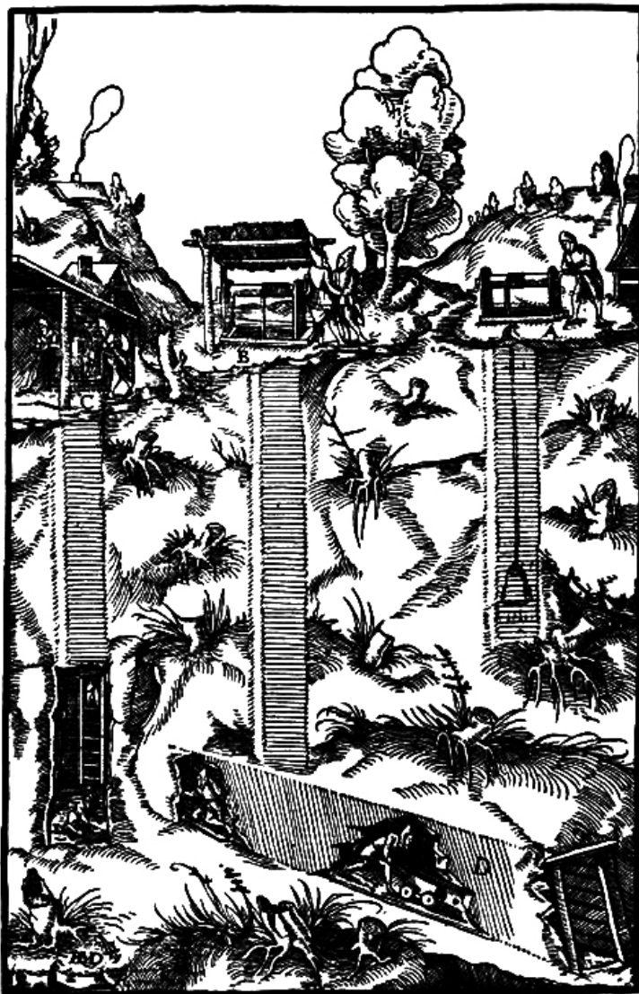
Rys. 2. Transport kopalniany, wg „De Re Metallica”, Georgius Agricola, XVI w.
