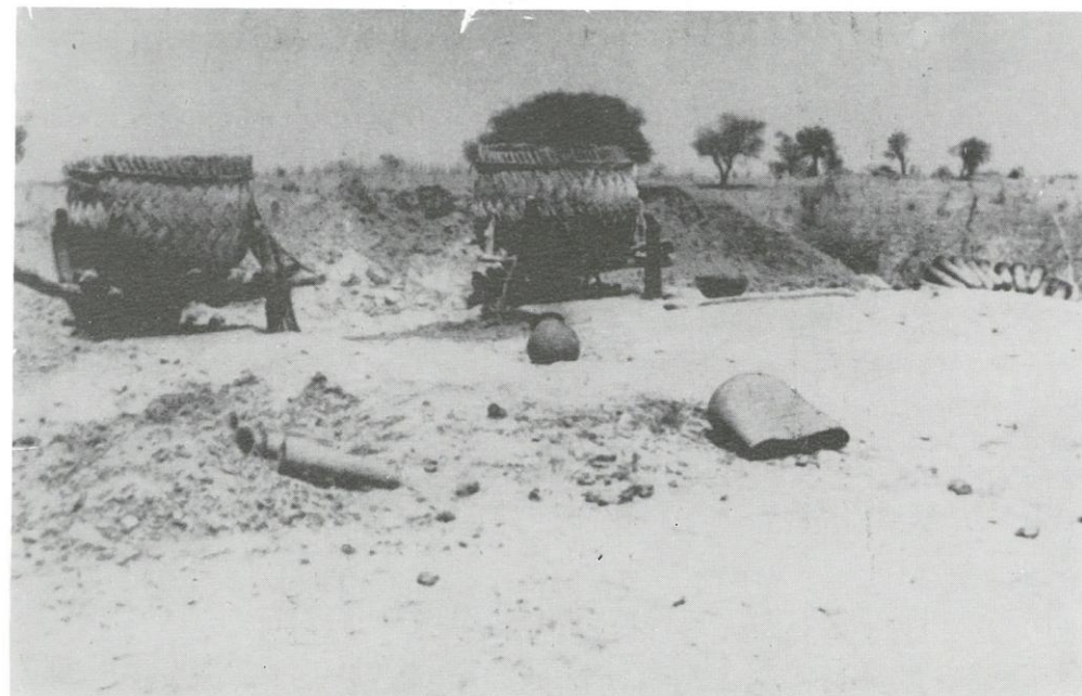
Fot. 7. Okręg N'Guigmi i Mainé-Soroa nad Jeziorem Czad w Afryce (Niger). Filtry roślinne do ługowania solanki z popiołu spalonych roślin (wg Y. Ponceleta)
