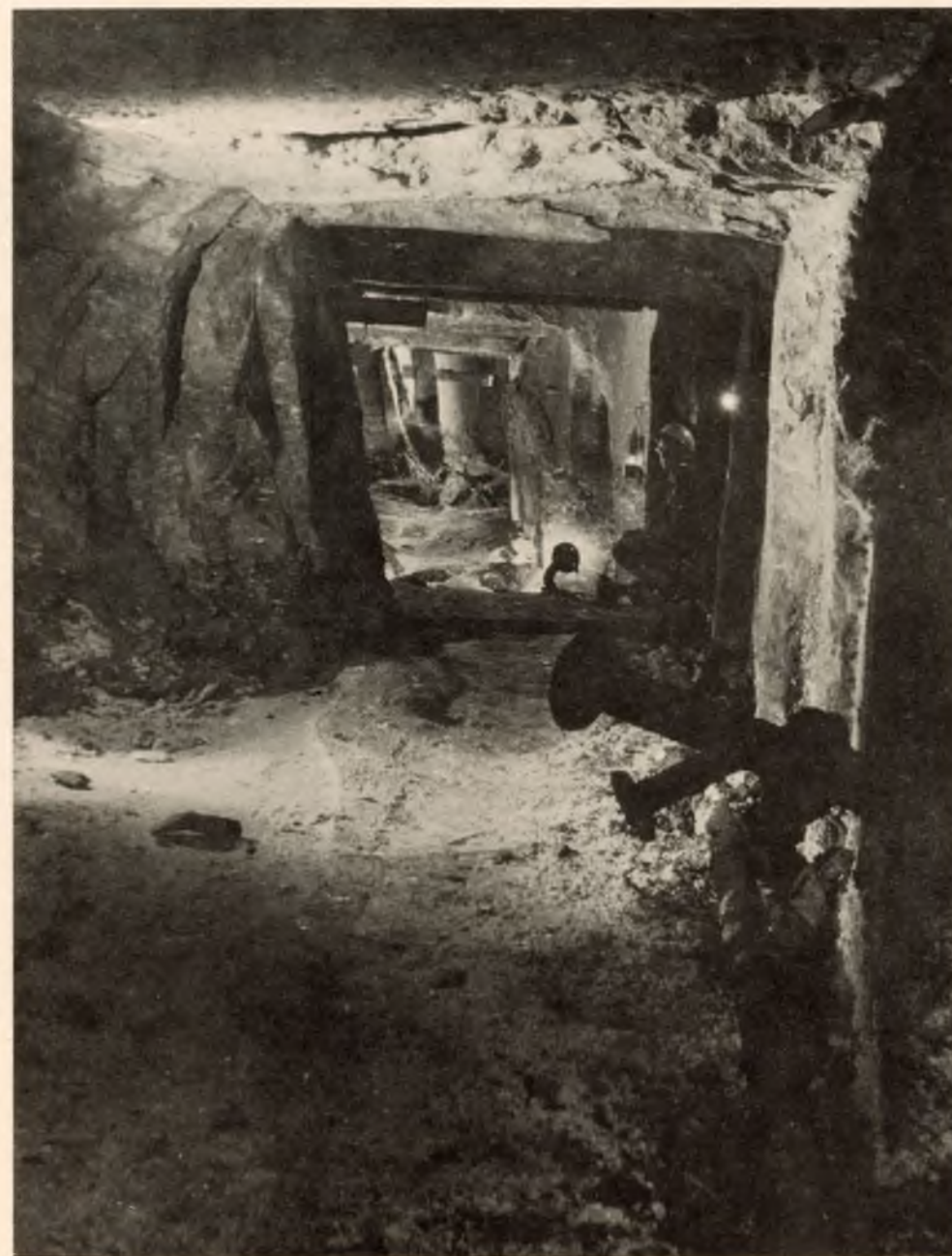
Ryc. 5. Rury obsadowe zamykające ługownie otworowe oraz główny rurociąg solankowy w chodniku z zaciosami charakterystycznymi dla „suchej”, ręcznej eksploatacji (między poziom Kołobrzeg)
