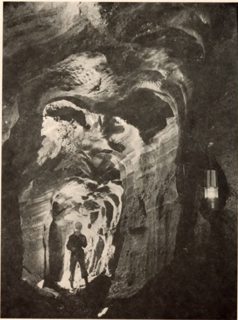
Ryc. 10. Profil chodnika wylugowanego w smugowanej soli szybikowej metodą „mokrą”, systemem natryskowym (między poziom Kotobrzeg)
