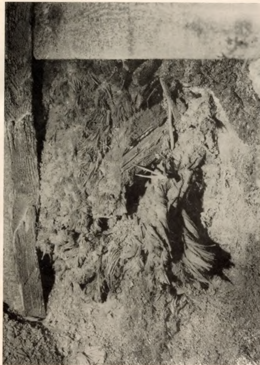
Ryc. 9. Liny szybowe z łyka lipowego (podsadzka w rejonie szybu „Regis”, poziom III)
