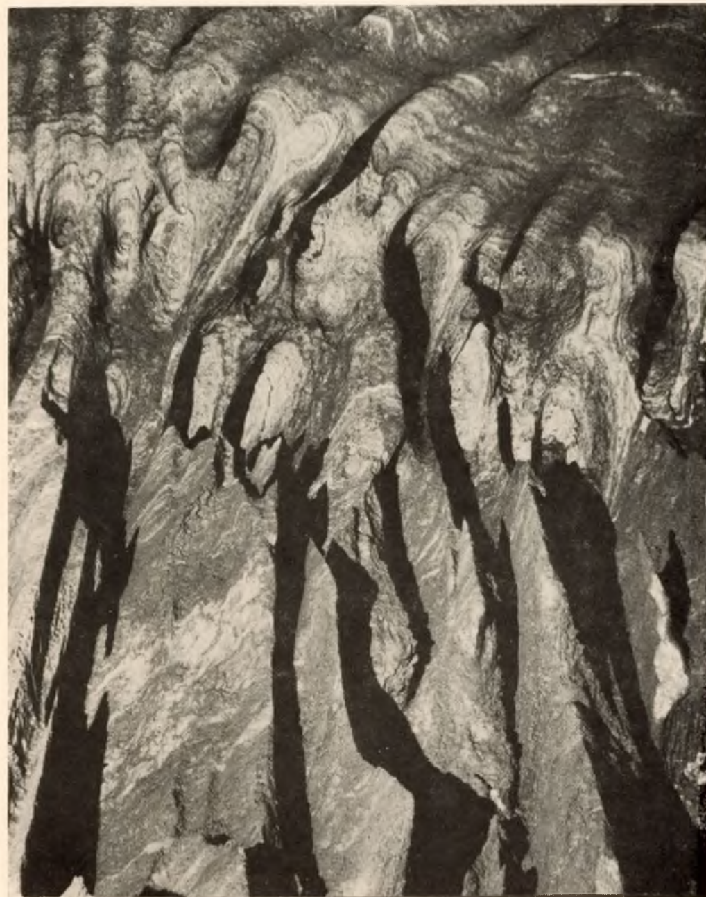
Ryc. 11. Fragment stropu i ściany komory „Muśnicki”, wybranej w bryle soli zielonej laminowanej, metodą „mokrą”, systemem natryskowym (poziom II wyższy)
