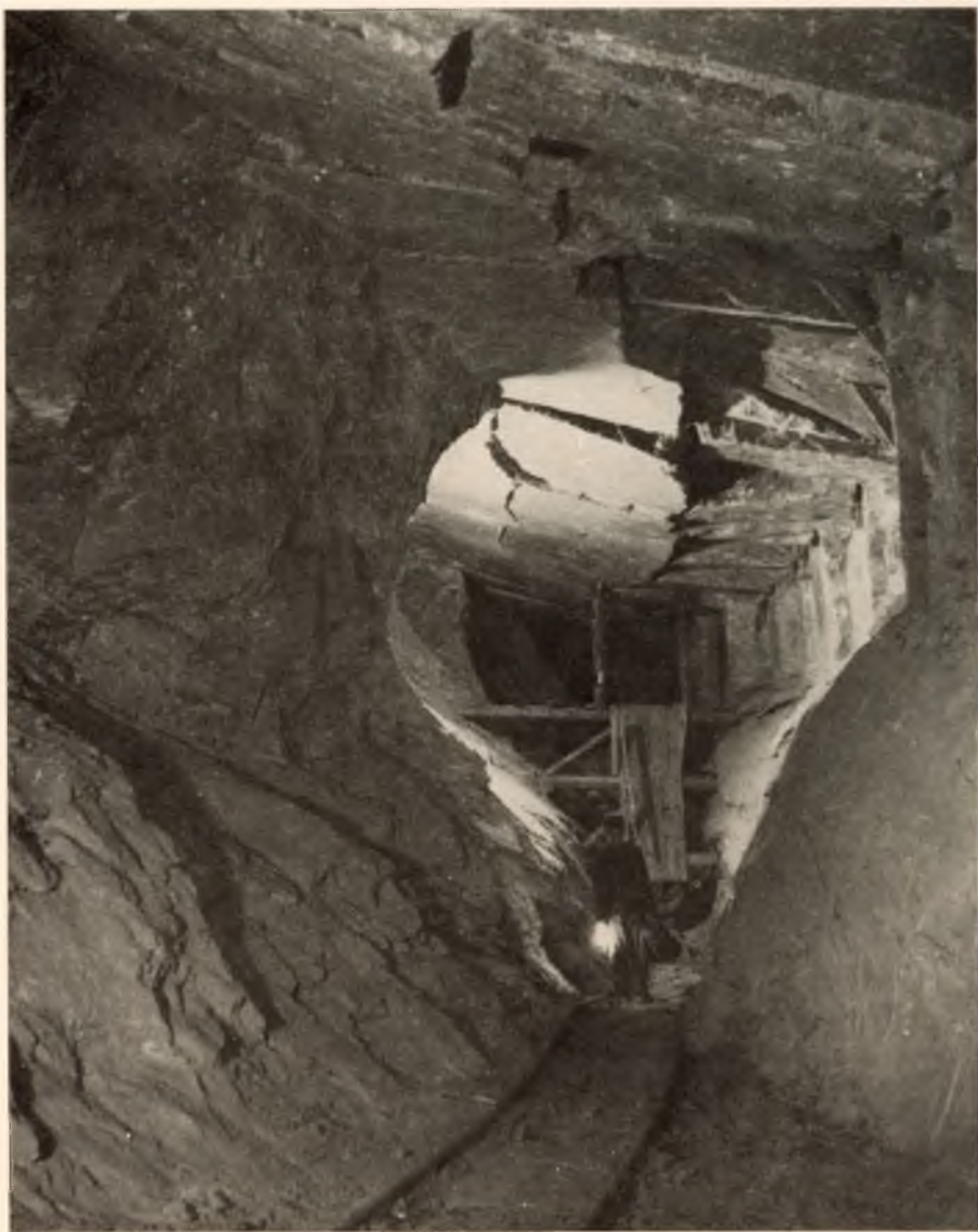
Ryc. 2. Komora i chodnik wykonane wrębiarką udarową „Demag”
