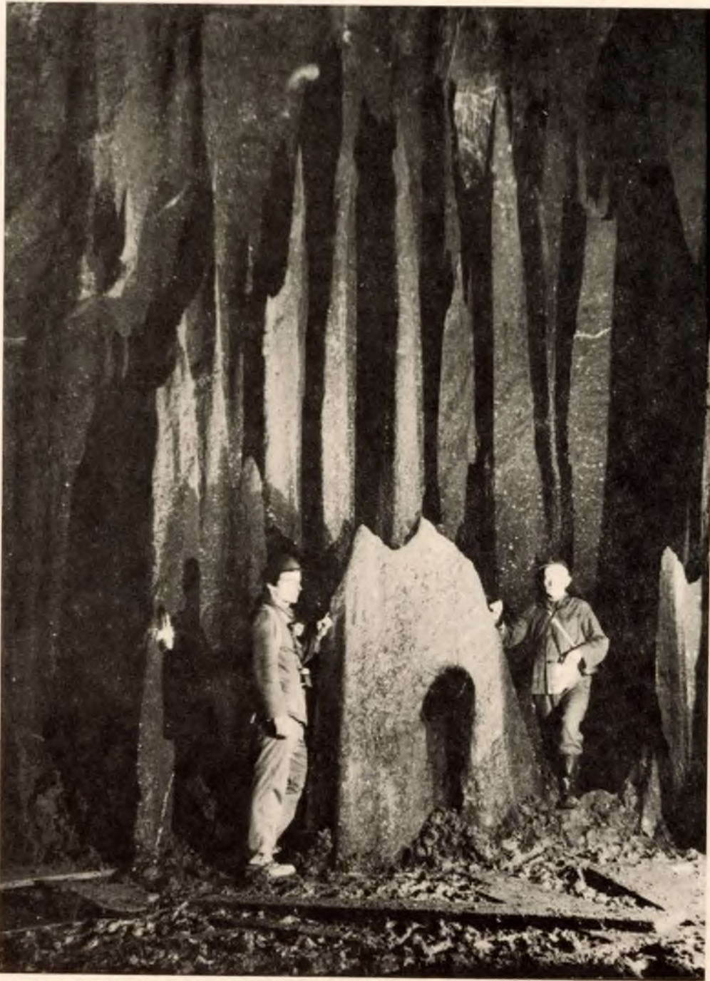
Ryc. 12. Bogato „urzeźbiona” ściana komory „Muśnicki”, wylugowanej systemem natryskowym (poziom II wyższy)
