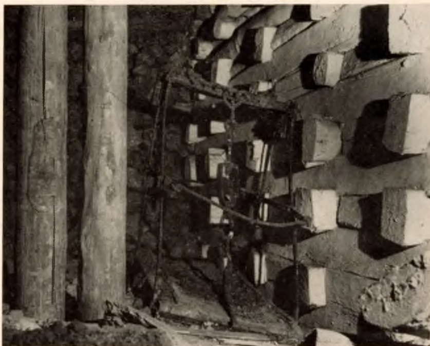
Ryc. 6. Klatka szybikowa typu „szala” z szybiku August, poziom III
