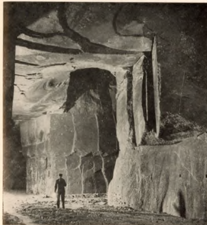
Ryc. 3. Komora „Witos” wykonana wrębiarką „Demag”
