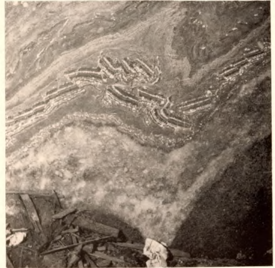
Fot. 1. Charakterystyczne zjawisko, tj. zaburzenie „mikrotektoniczne” na ścianie chodnika poprzecznego (po lewej stronie — południe, po prawej — północ)
