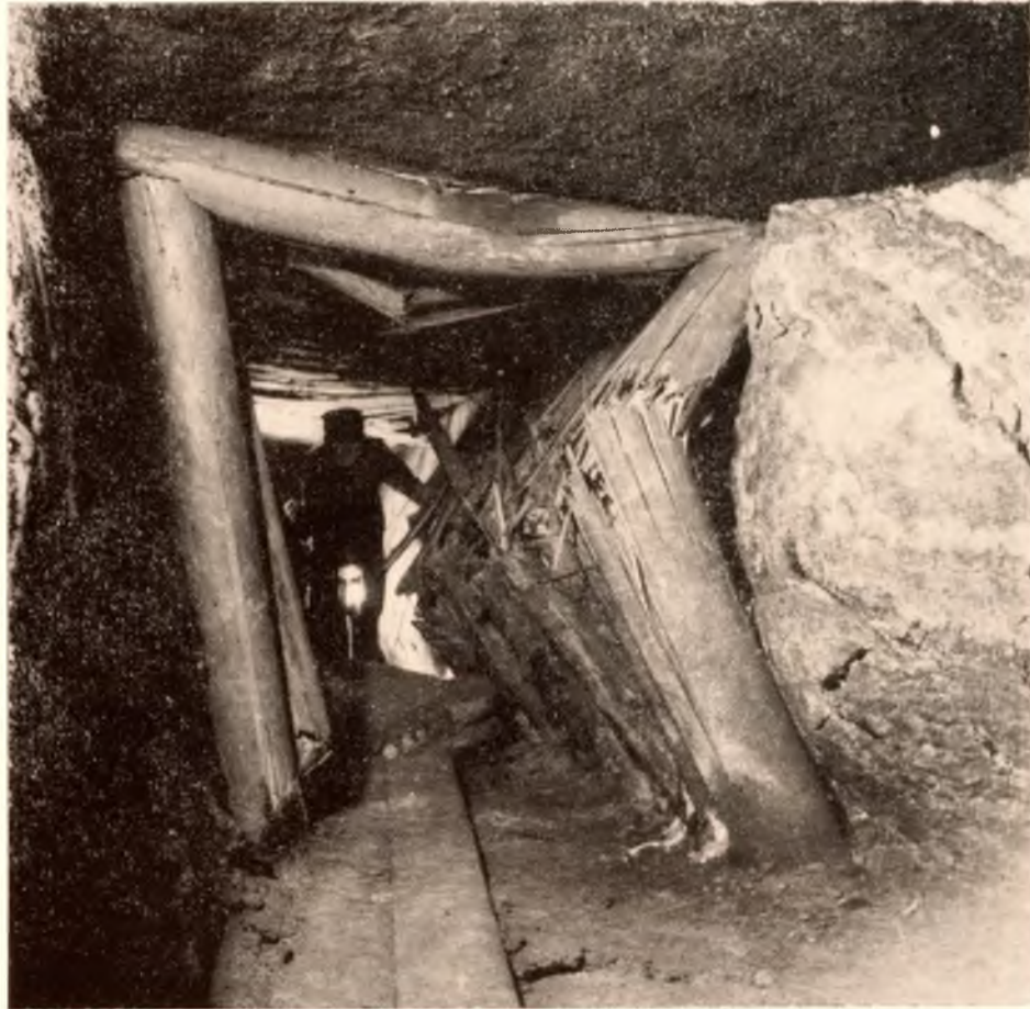
Fof. 2. Charakterystyczne zaburzenia geodynamiczne w chośniku podłużnym w solach spizowych
