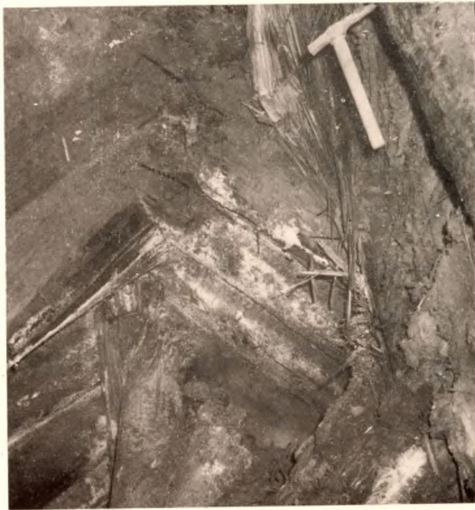
Fot. 2. Obudowa drewniana szybu „Goryszowskiego” z widocznym odstąpieniem iłłów mioceńskich
