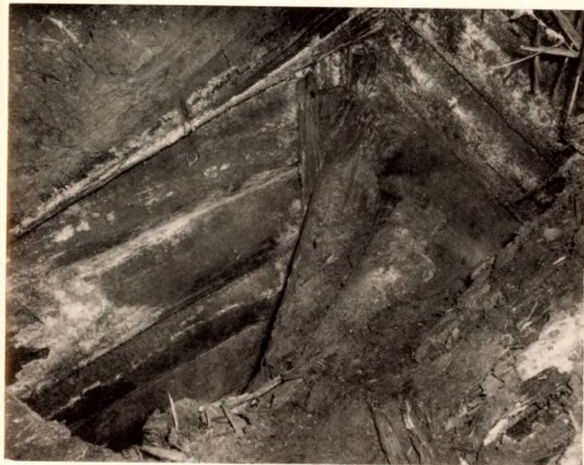
Fot. 1. Fragment obudowy drewnianej szybu „Goryszowskiego” podczas badań archeologicznych
