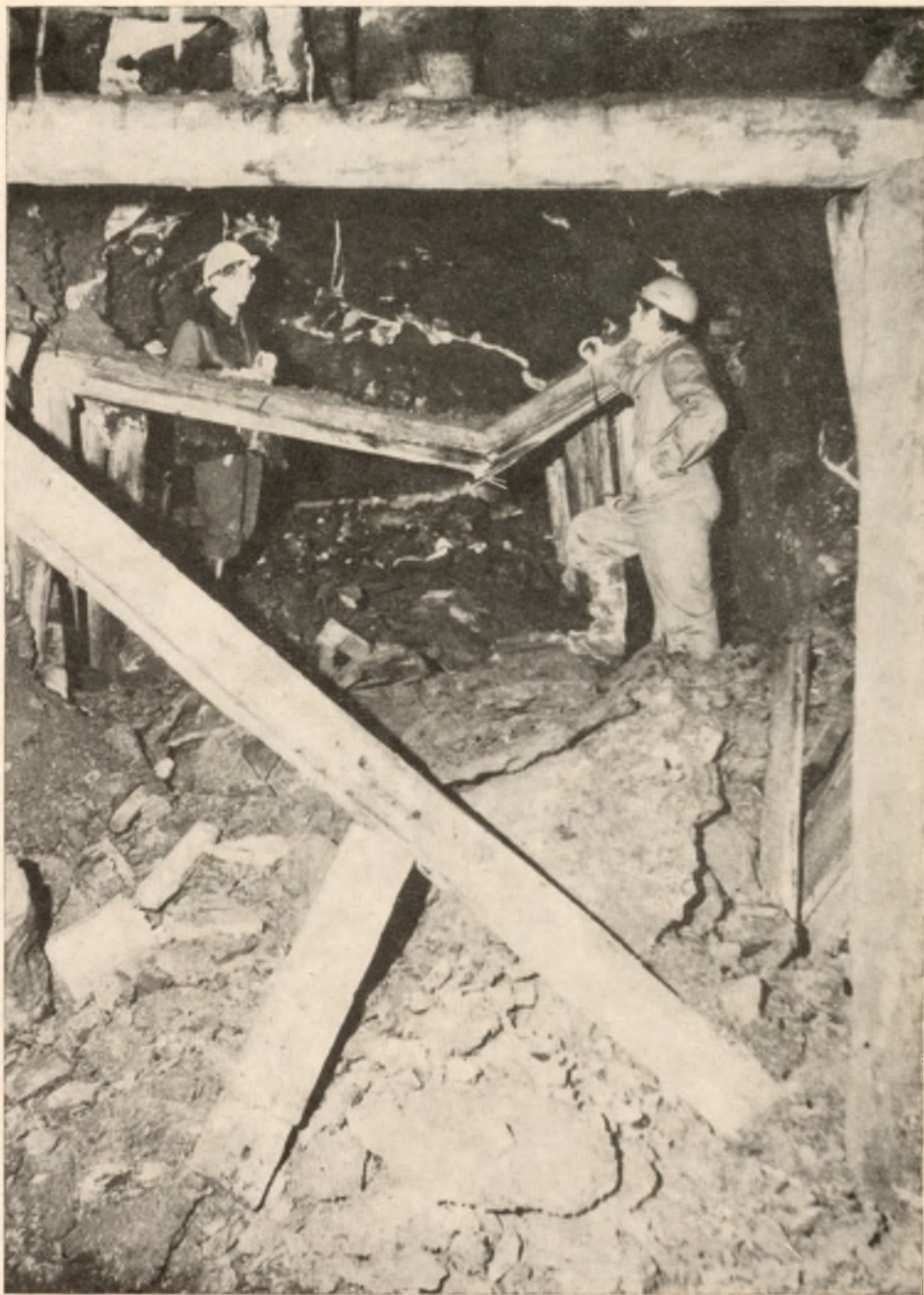
Fot. 6. Obwiał stropu zamykający wejście do komory „Międzykasztę”
