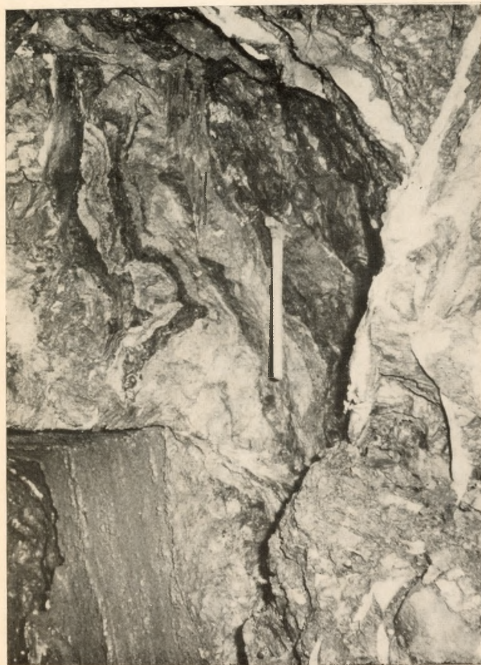
Fot. 1. Obwał stropu chodnika „Bąkle”
