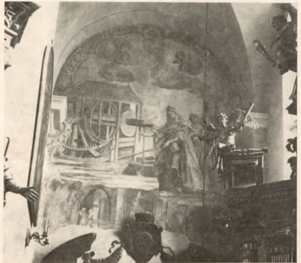
Fot. 8. Kierat trybowy z hamulcem łątkowym z XVIII w.; fresk w kościele parafialnym w Bochni
