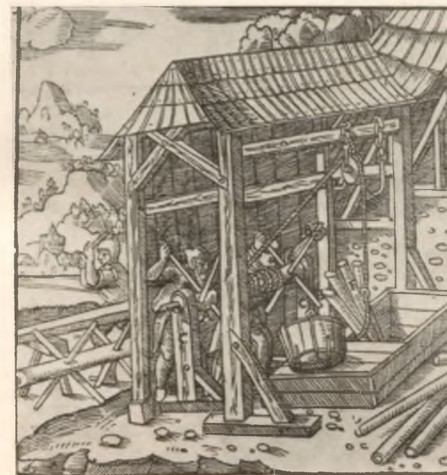
Fot. 2. Kołowrót z rogami z XVI w. (wg G. Agricoli)
