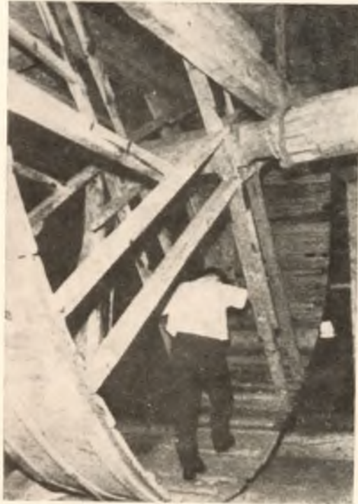
Fot. 3. Koło dreptakowe wewnętrzne z Henrykowa
