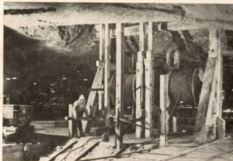
Fot. 11. Urządzenie hamulcowe pochylniane
