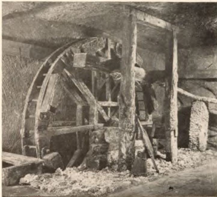
Fot. 4. Koło dreptakowe zewnętrzne, czerpakowe z kopalni bocheńskiej
