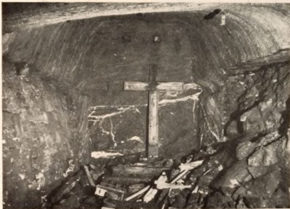
Fot. 4. Kaplica Sw. Krzyża w komorze „Piżmowa”, poziom I. Widok na zniszczony ołtarz
