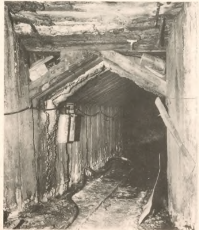
Fot. 6. Wzmocniona obudowa poprzecznika „Trinitatis”
