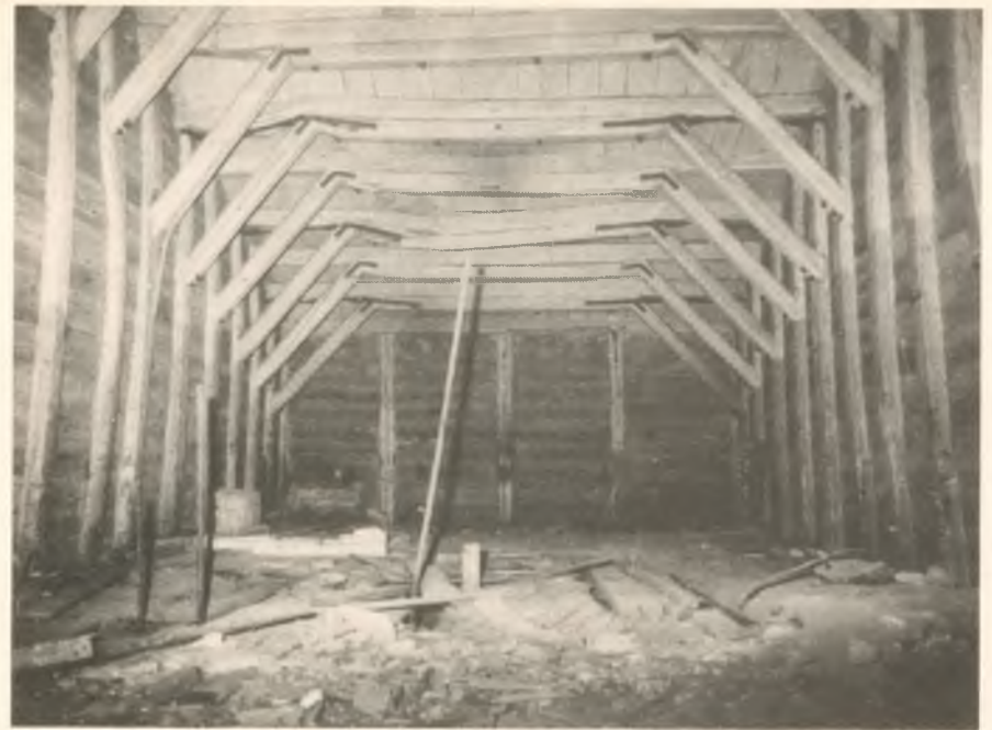
Fot. 5. Zabezpieczenie nadszybia szybiku „Mazurkiewicz”
