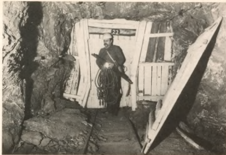
Fot. 9. Tama wentylacyjna w podłużni „Podmoście”
