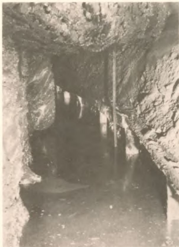
Fot. 8. Ciąg wody w podłużni „Danielowiec”
