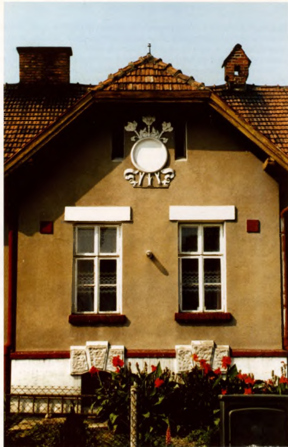
Fot. 4. Secesyjny detal domu
