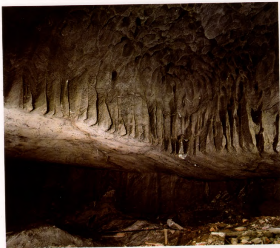
Fot. 2. Komora Lill Górny ze śladami eksploatacji ręcznej i ługowniczej z podsadzką na spagu
