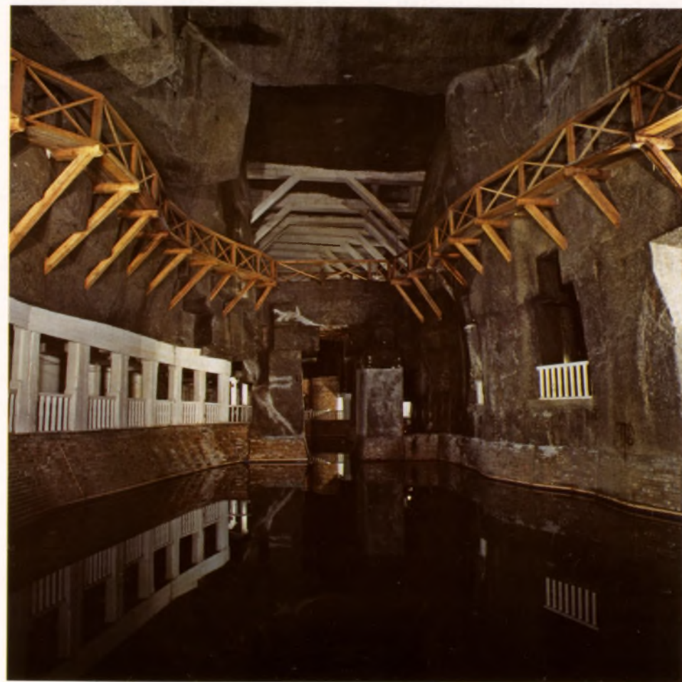
Fot. 6. Komora Wessel po zakończeniu prac zabezpieczających w latach 90. XX w.
