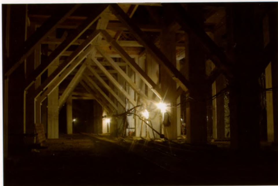
Fot. 4. Komora Gołuchowskiego w końcowej fazie rekonstrukcji zniszczonej obudowy
