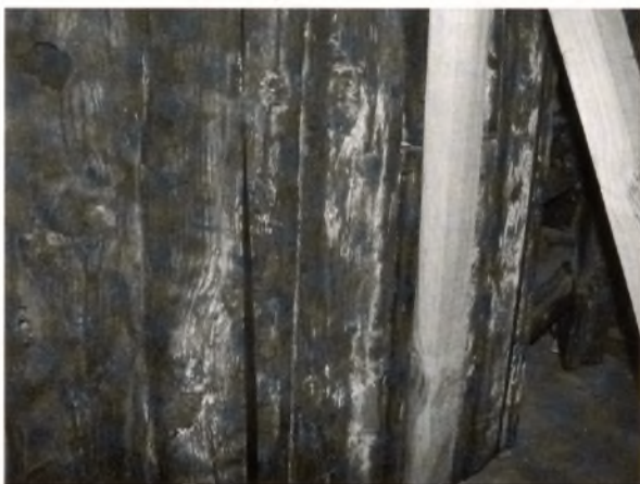
Fot. 2. Sole nieorganiczne na zabytkowym drewnie wraka z XVII w.
