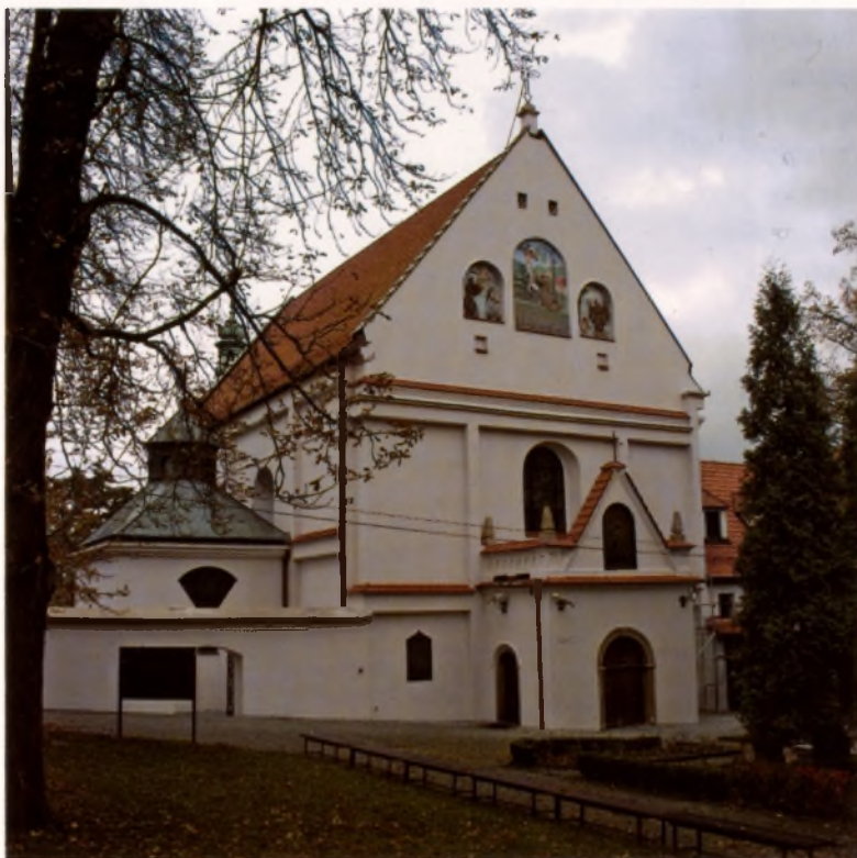
Fot. 4. Fasada kościoła klasztornego
