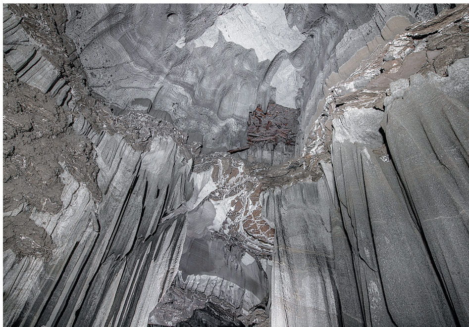
17. Komora Korytno dołem z widocznym podsadzonym chodnikiem w przystropowej części, fot. D. Kolakowski, 2021
