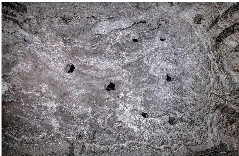
18. Fragment stropu komory ługowniczej przy podłużni Siercza z widocznymi rowkami, powstałymi w trakcie eksploatacji „mokrej”, fot. D. Kolakowski, 2021
