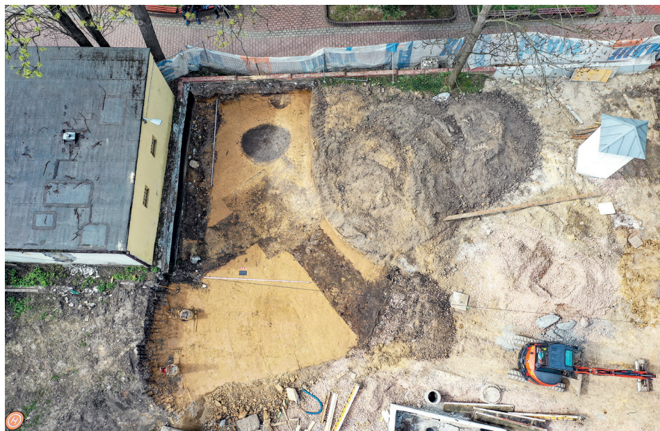
9. Odhumusowany i wyplantowany obszar Wykopu VI
