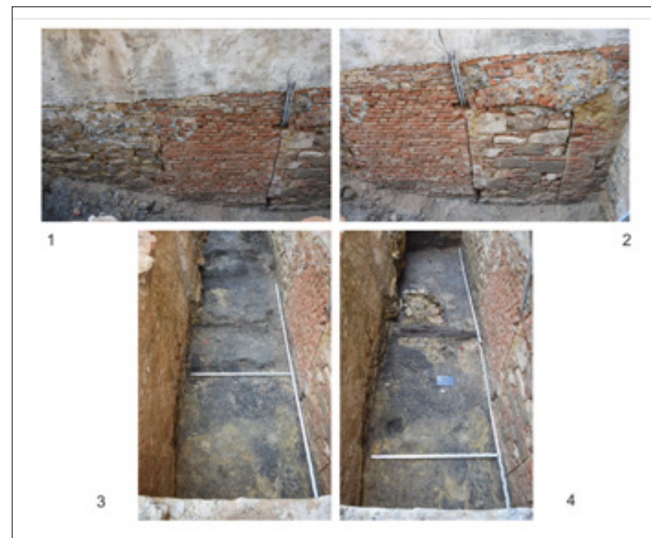
Ryc. 3. Dokumentacja fotograficzna odkrytego portalu i przemurowania z nim związanego, jak również poziom zejścia do portalu w momencie zakończenia odgruzowywania i po wyczyszczeniu, a także w momencie odkrycia drewnianej belki i podmurówki, które stanowiły elementy schodów (zdjęcia i tablica autorstwa P. Sewuloka)
