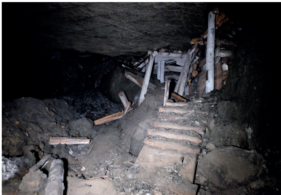
11. Komora „Lipowiec” na poziomie II niższym – stan obecny (2019 r.), R. Zadak. 11. The “Lipowiec” chamber on the lower level II – current condition (2019), photo by R. Zadak.
