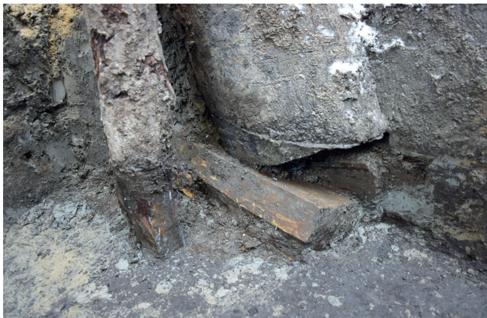
8. Sposób posadowienia pali (fot. P. Sewulok).
